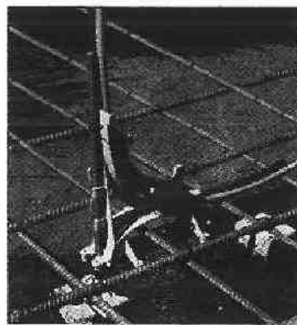
بست خم ۹۰ درجه در انتهای لوله قائم بست خم ویژه لوله در اتصال شیرآلات بهداشتی شکل (۴-۳-۷-۱۶) - استفاده از بست مخصوص خم در نقطه انتهایی تبدیل لوله قائم به لوله افقی در لوله‌کشی‌های مسی و پلاستیکی
