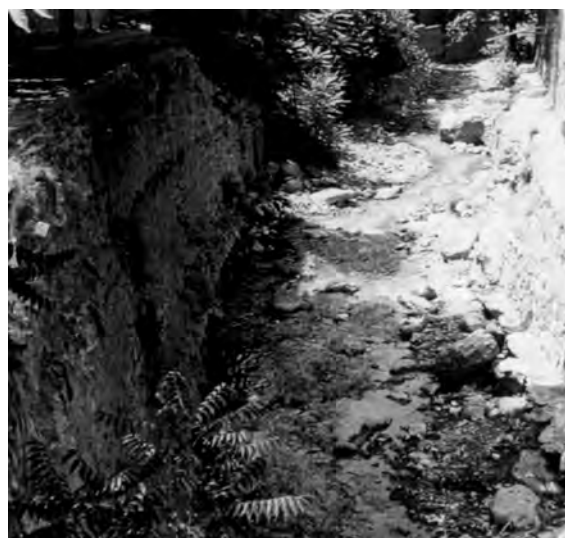
تصویر (۲۸) - زباله، دیواره‌های سنگی، پس رود چه شد ؟
