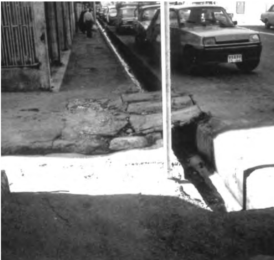
تصویر (۴۸) - پل، مفصلی برای ارتباط دو مکان! (کوچه و خیابان محلی)
